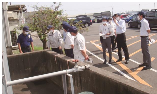
油タンク点検の様子
