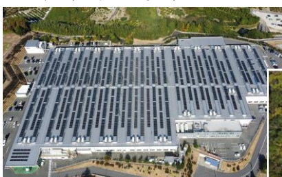
オティックス幡豆 蒲郡工場 太陽光パネル
